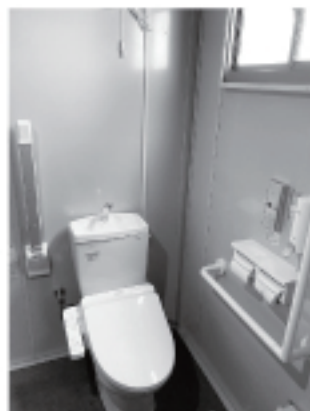
仮設の多目的トイレ
