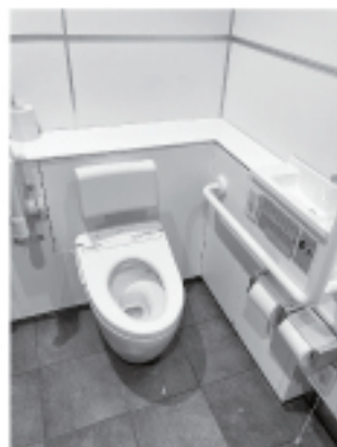
改札内多目的トイレ
